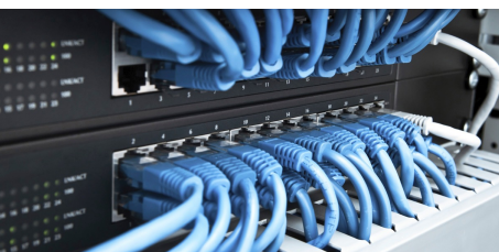
CCDD y CCTV
